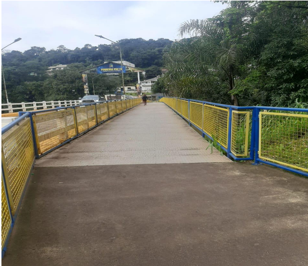
Local 01 - Passarela da ponte municipal Humberto Bresolim.
