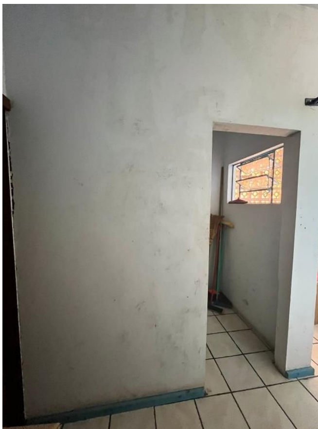
Figura 02: uma das paredes que será removida
