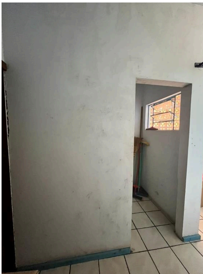
Figura 02: uma das paredes que será removida
