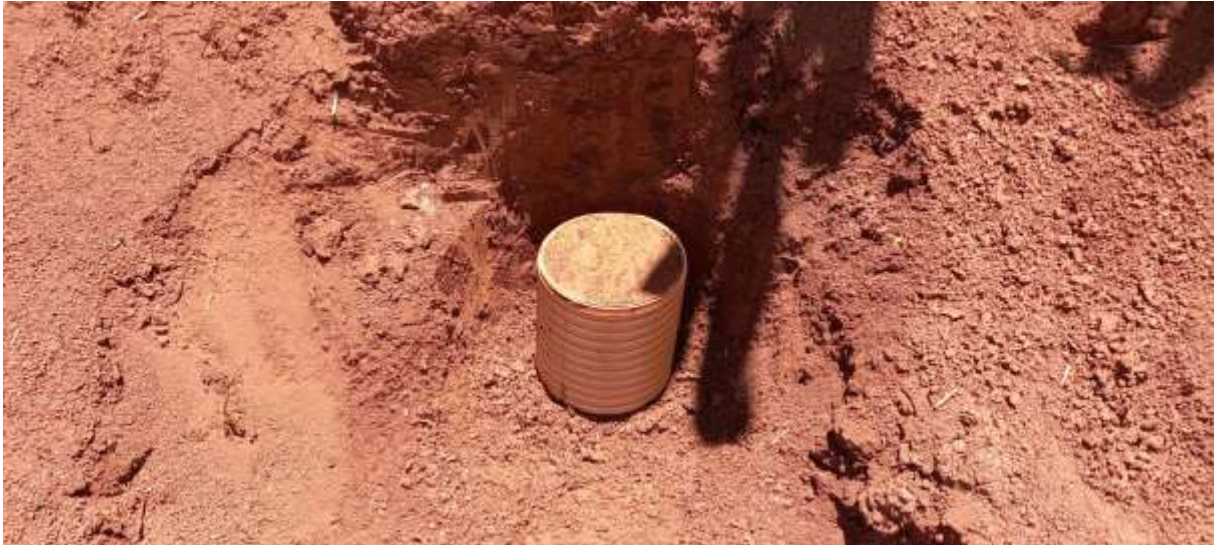
Figure 10 – Escavação do bloco da AM 02 – Fonte: v7/2022
