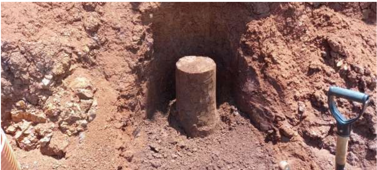
Figure 11 – Escavação do bloco da AM 03 – Fonte: v7/2022
