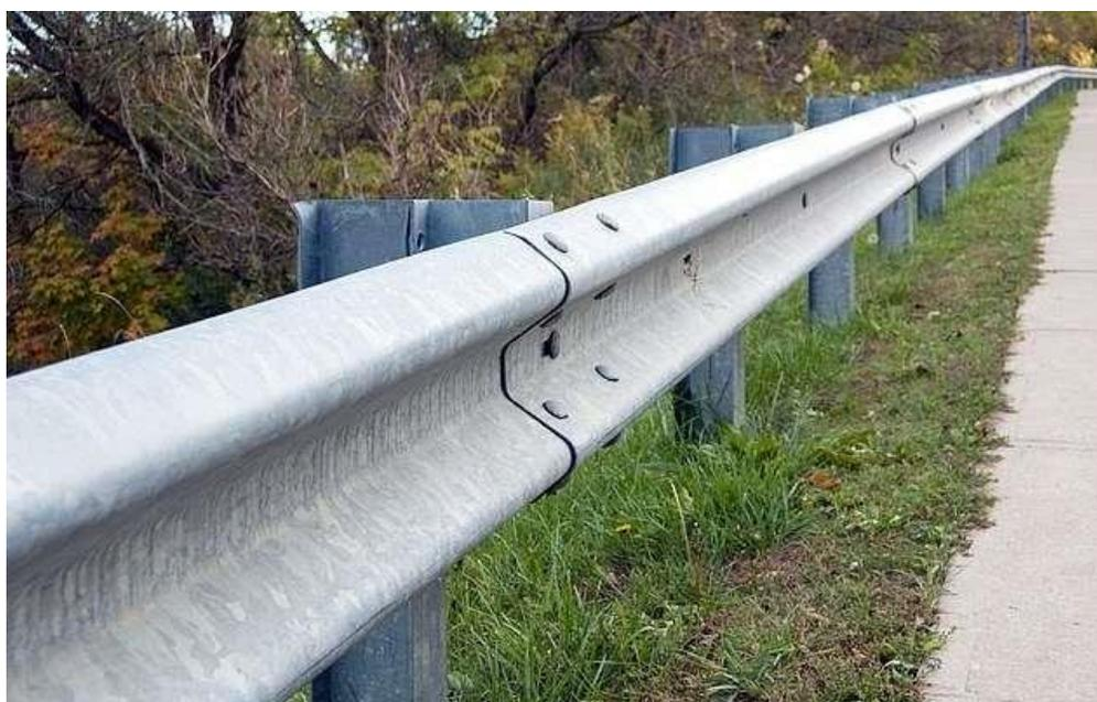
**Figura 01: Defesa metálica**
