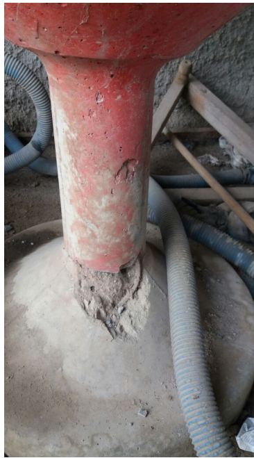
PEDESTAL EM CONCRETO
