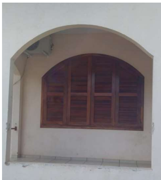
Vão "Janela" (2 unidades) Guarda corpo modelo 2 (altura = 90 cm, instalado a 110 cm do piso)
