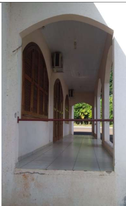
Vão lateral Guarda corpo modelo 1 (altura = 110 cm)
