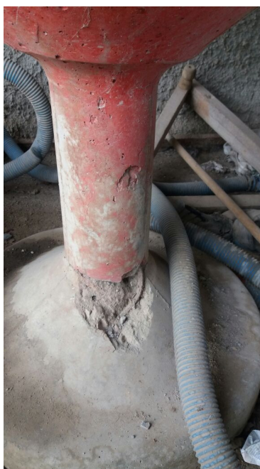
PEDESTAL EM CONCRETO
